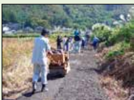
未舗装農道の舗装
