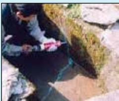
ひび割れの補修
