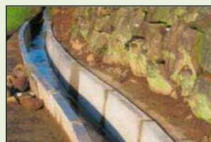
素堀り水路からの更新
