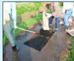
農道の部分補修
