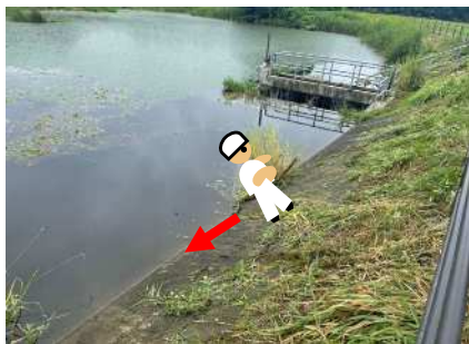
(ため池堤体の急傾斜)
