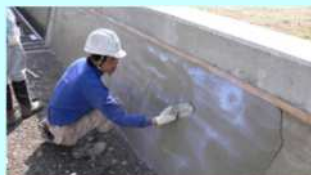
老朽化した水路壁のコーティング
