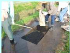
農道の部分補修
