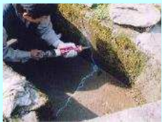
水路のひび割れ補修
