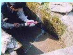
水路のひび割れ補修
