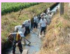
水路の泥上げ
