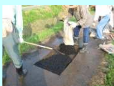
農道の部分補修
