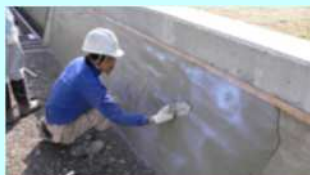
老朽化した水路壁のコーティング
