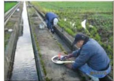
自主施工による目地補修
