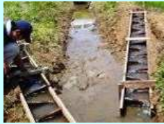
水田魚道の設置
