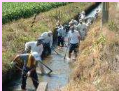
水路の泥上げ
