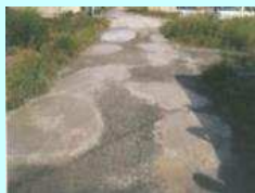
農道の窪みの補修
