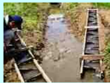
水田魚道の設置
