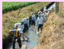
水路の泥上げ
