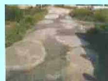
農道の窪みの補修
