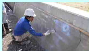
老朽化した水路壁のコーティング
