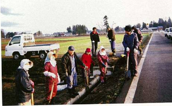
水路の土砂 上げ・清掃
