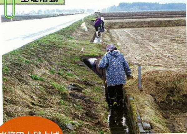
水路の土砂上げ ・清掃
