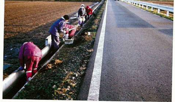
水路の土砂 上げ・清掃
