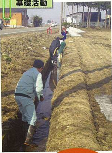
水路の土砂上げ ・清掃
