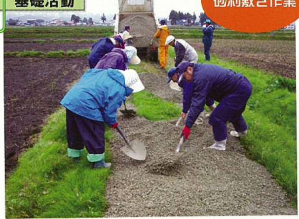
砂利敷き作業
