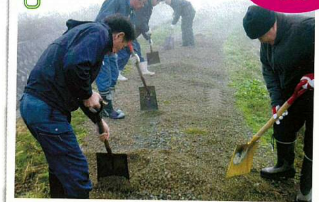
農道の敷砂利 作業
