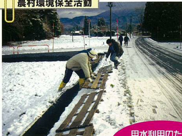
用水利用のため の水路への防雪 蓋掛け作業
