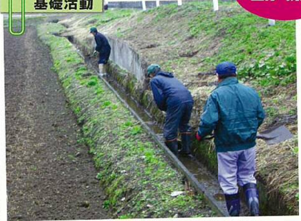
水路の土砂 上げ・清掃
