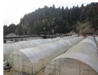
【パイプハウス】
