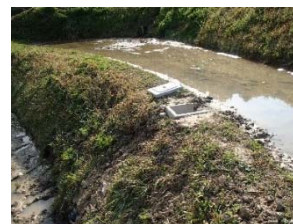
【排水路の整備】
