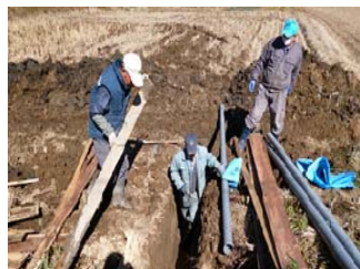
【自主施工による簡易な基盤整備】
