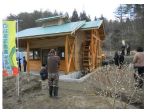
【平成24年建設の水車小屋】
