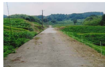
【電気柵の設置】
