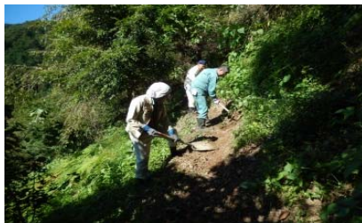
【共同作業（農道管理）】
