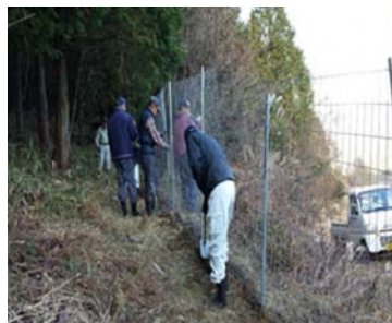
【獣害防止柵の設置】
