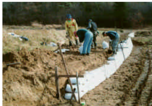
H20年農道法面大改修(場所~おきさ街道)
