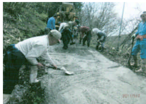
農道の急勾配区間の補修を行いました。
