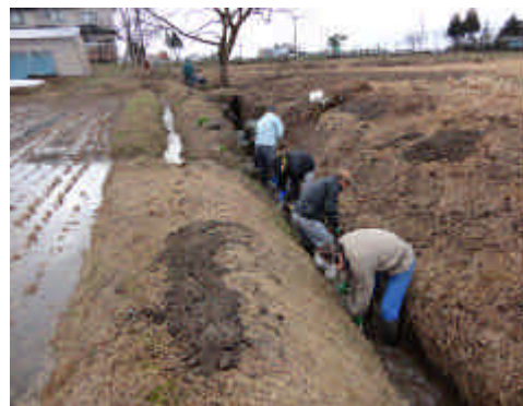
排水路の泥上げ作業
