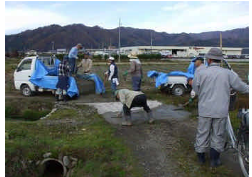
農家の方々に呼びかけて一緒に共同実施した農道の検査・修理・舗装活動です。
