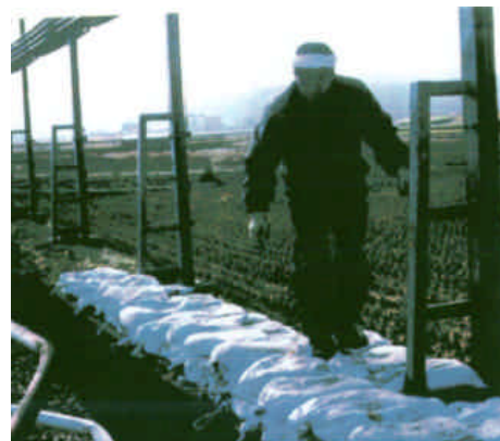
用水路の土砂上げ作業を行い水の溢れる箇所を土を積み上げ 水が溢れるのを防ぐことができました。
