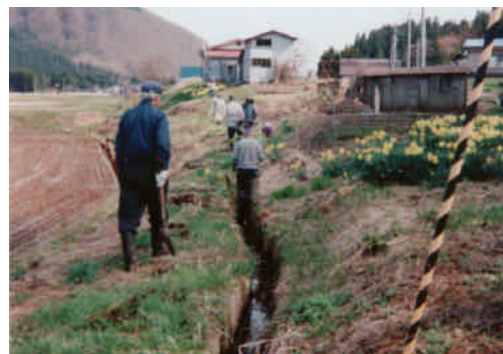
水路の泥上げ作業
