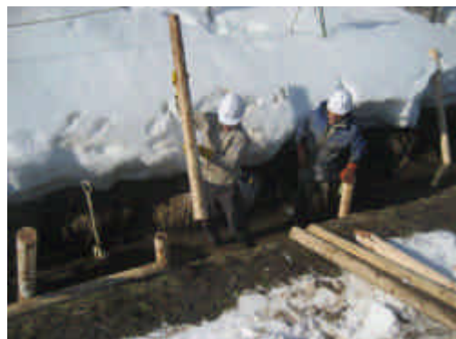
素堀水路の崩落防止、通水改善のために間伐材を使用し水路の改修を行います。
