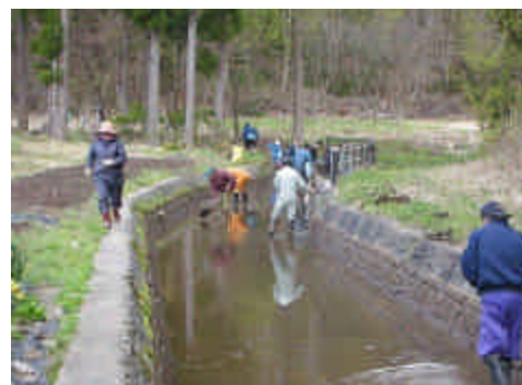
農業用水路清掃状況
