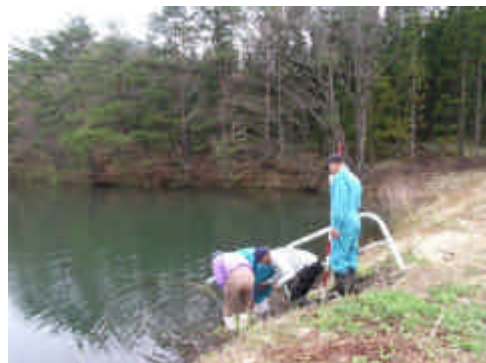
斜樋点検風景
