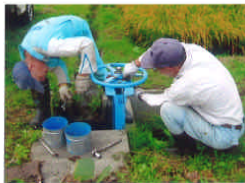
共用開始から20年経って、18カ所のゲートは劣化が進んでいたが5年間ですべて補修し保全した。
