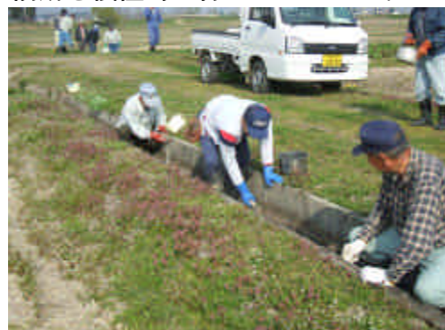
地域住民の協力を得ながら、用水路の目地補修を行いました。
