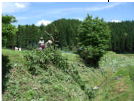
落差10mの法面、雑木伐採中)
