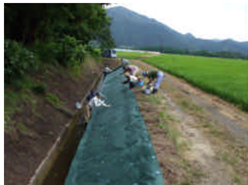
草刈り作業軽減のための防草シート 施工
