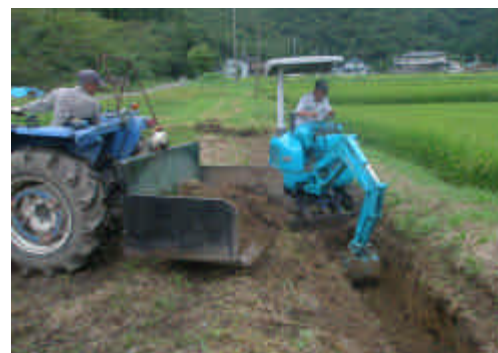
集落は用水貴重な為、用水路の補修作業を行いました。
