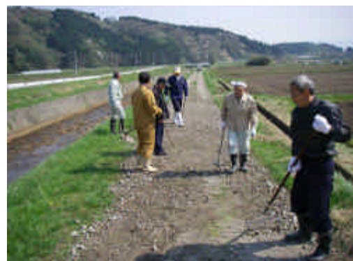
砂利敷きによる農道整備により、景観も整い通行への支障がなくなった
