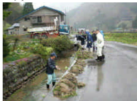
水路の清掃、泥あげ、水草の過繁茂抑制を適度におこないきれいな水路にしました。
