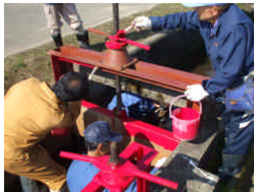
大切な農業用施設を末永く使うため、分水ゲートの塗装を実施しました。
