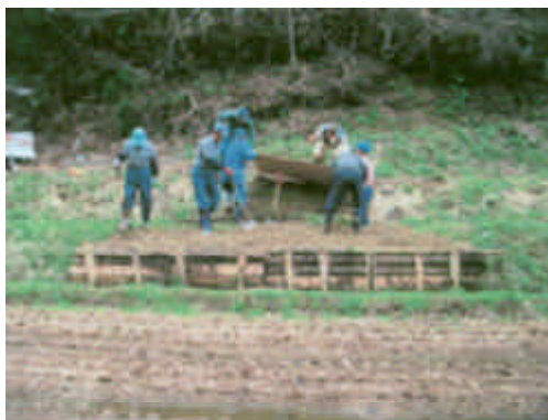
大雨等の被害多発し水路法面の崩落6ヶ所及び水路U字溝の被害等発生し補修することができました。
