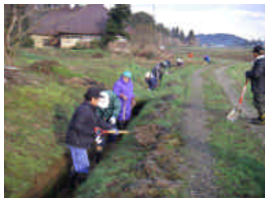
共同作業により、水路の維持管理が容易になった。
