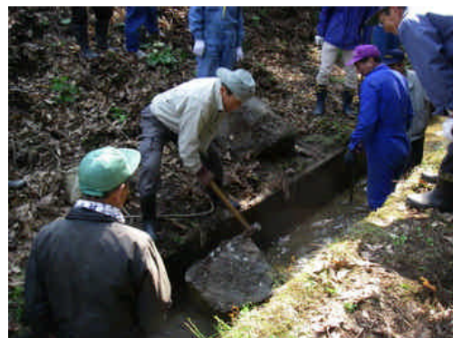
共同作業で水路に落ちてきた岩の除去作業を実施しました
