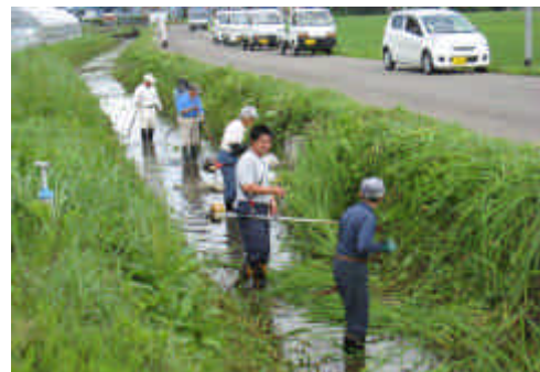
通水機能の維持を図り生活環境をよくする為、4月と7月の年2回、40名前後の参加者により大堰の草刈り、泥上げ作業をしました。
