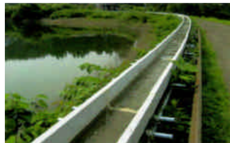
この辺りでは、以前は水路が溜め池の上手を大きく迂回していたためにスムーズな流下が妨げられていました。今回、U字溝と単管を使った捷水路を新設しました。その結果、流量が画期的に改善されました。
