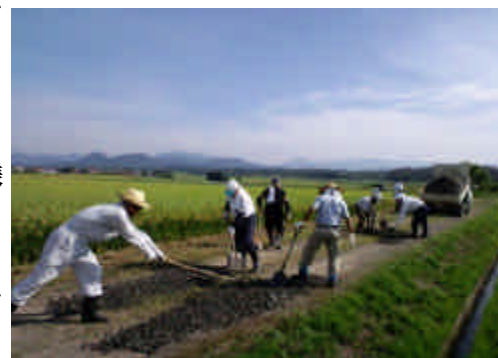
毎年8月下旬に構成員のほとんどが参加し、農道の路面・路肩の凹凸及び軟弱箇所に砂利を敷き、9月の稲刈り作業に備えます。
