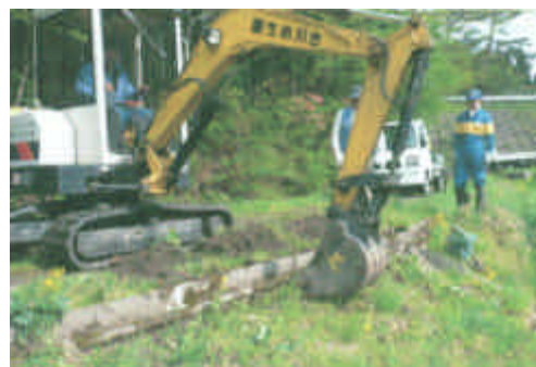
重機を使った水路の補修作業。今までは出来なかった作業が出来ました。
