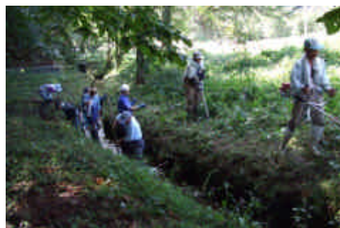
湧水が豊富な水路の整備 (清水な小川)
