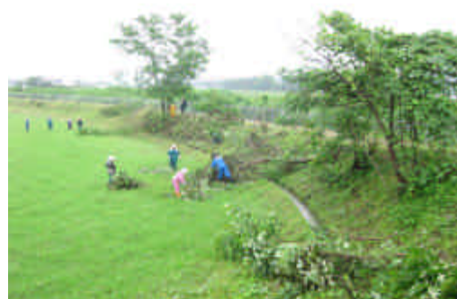
休耕田の荒廃を防ぐ為、支障木の伐採
