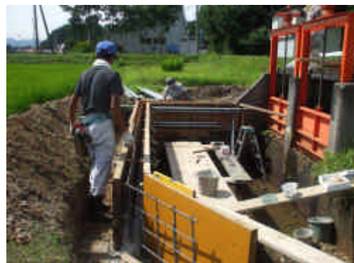
増水時に法面崩落につながっていた施設の改修を行いました。自分たちでできるのは保全会ならではの事です。
