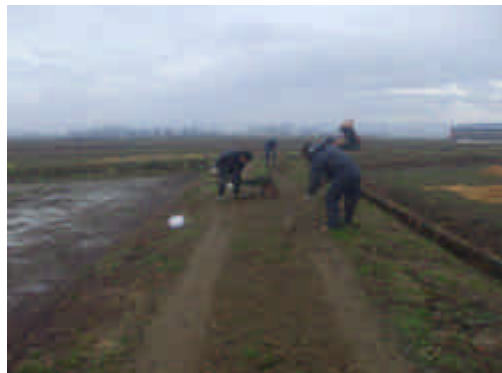
中央の段差を削り砂利の補充をした農道。通行しやすくなり喜ばれています。
