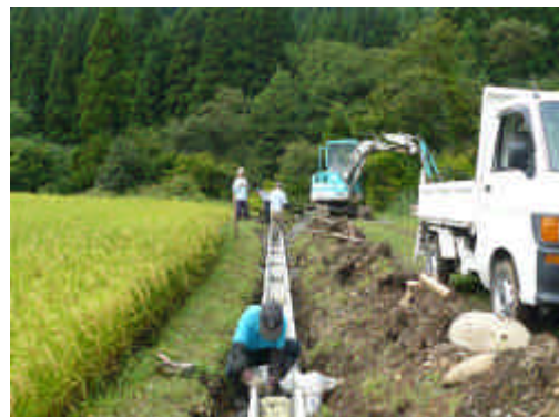
長さ70mの素堀水路であったのをU字溝を購入し取り付けした。
