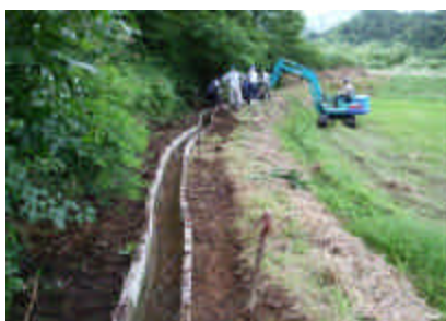
斜面沿いの素掘り水路に敷設工事中)
