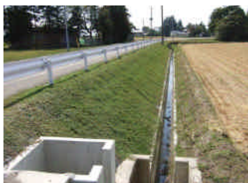
道路路肩等へカバープランツの施工により雑草対策が容易になり景観が保たれるように成った。
