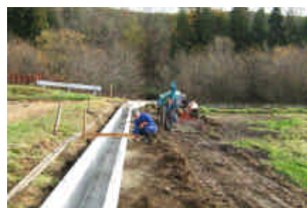
破損U字溝を新品と交換)
