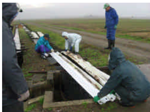
積雪被害防止活動として水路の蓋掛けを毎年実施しています。生活用水確保に役立っています。
