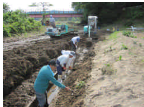
豪雨により、土砂で埋没した幹線用水路の泥上げを、被災翌日、地域一丸となり行いました。
