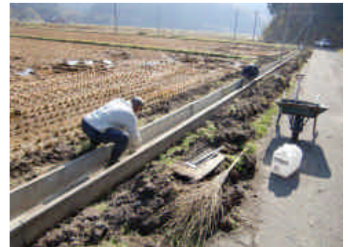
老朽化による側溝の補修作業
