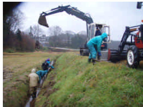
農家の直営による、未装工水路の整備が進み、維持管理の省力化が図られた
