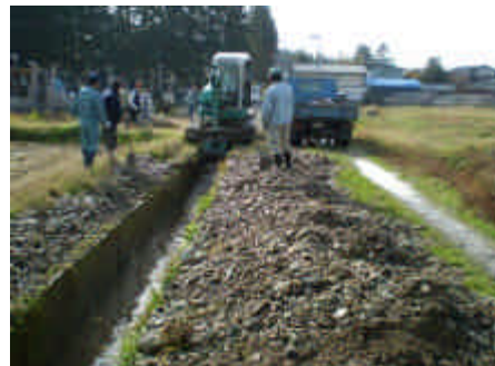
平成19年度からの活動期間中毎年のように沢からの土砂によって埋まってしまった堰の、構成員による土砂利の撤去作業。市町村への負担なく行えたのもこの事業のおかげです。
