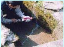
水路のひび割れ補修
