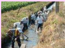
水路の泥上げ
