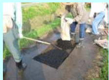
農道の部分補修
