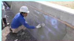
老朽化した水路壁のコーティング
