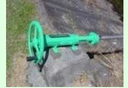
ゲート、バルブの更新
