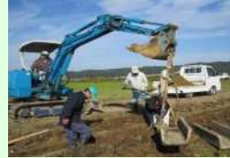
コンクリート水路の更新
