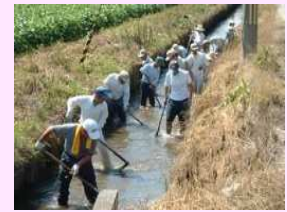
水路の泥上げ
