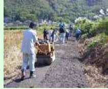
未舗装農道の舗装
