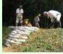
漏水箇所の補修
